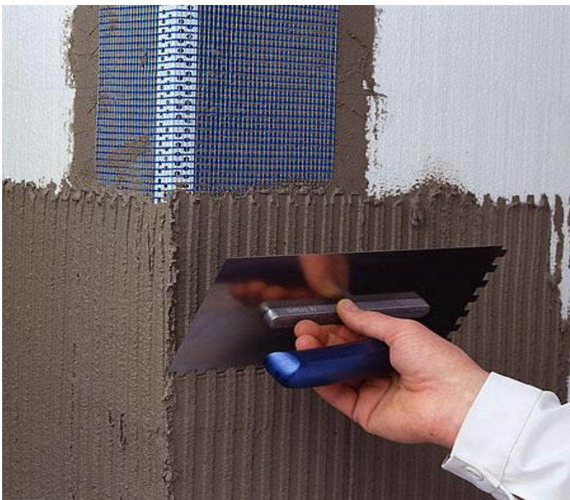
Τοποθέτηση ναλοπλέγματος
